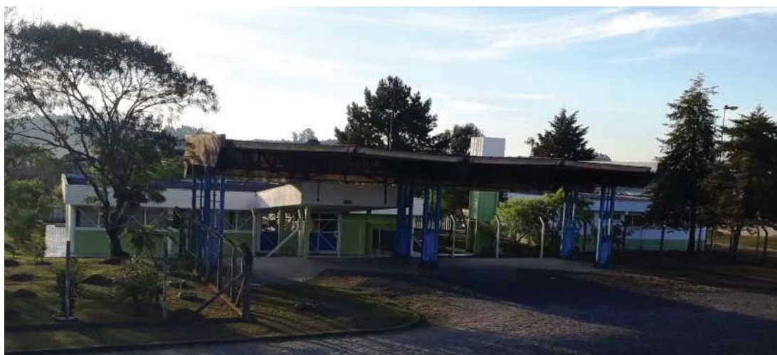
Rodoviária de Rio Azul funcionou até 2004 em prédio próximo ao ginásio de Esportes Albinão. Imagem: Rodrigo Zub
