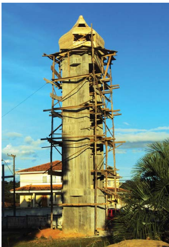
Novo campanário, quando ainda estava em construção em 2011
