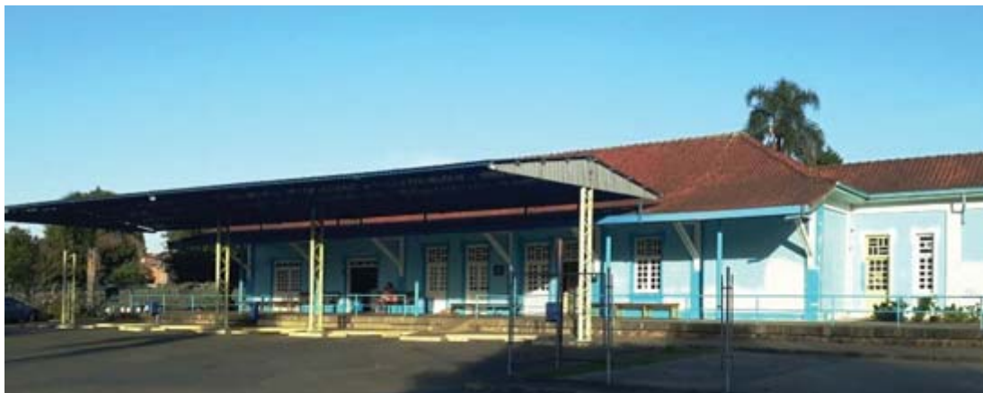
Antiga estação ferroviária hoje é sede da rodoviária municipal. Crédito: Rodrigo Zub
